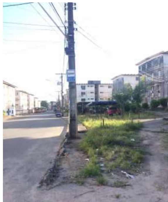
Figura 33: inexistência de calçada
