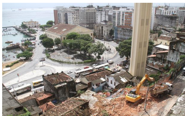
Figura 54 – Demolições de imóveis na Ladeira da Montanha, cartão-postal da cidade.
