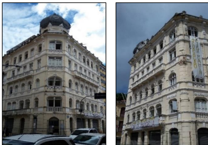
Figura 75 e 76 – Edifício sede da Ocupação Luísa Mahin.
