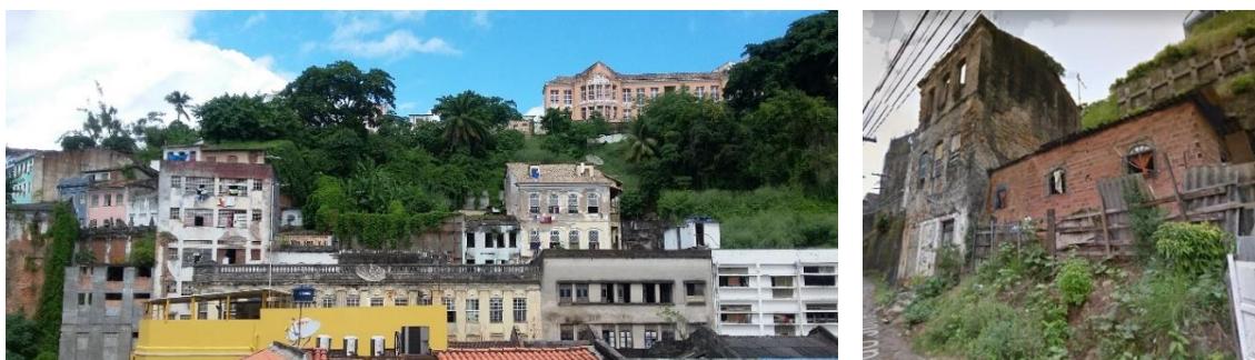
Figuras 83 e 84 – Imóveis junto à encosta do Frontispício e algumas ocupações
