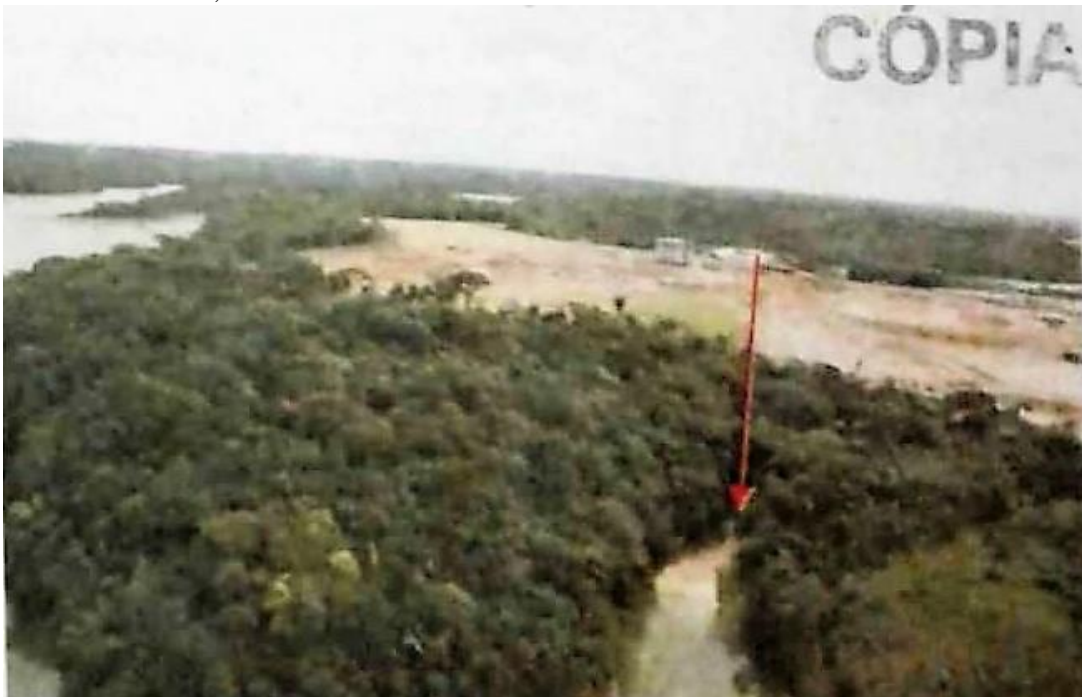
Figura 10 - Vistas da APP e área do empreendimento, com destaque para o risco de assoreamento da represa Ipitanga II Salvador, 2013
