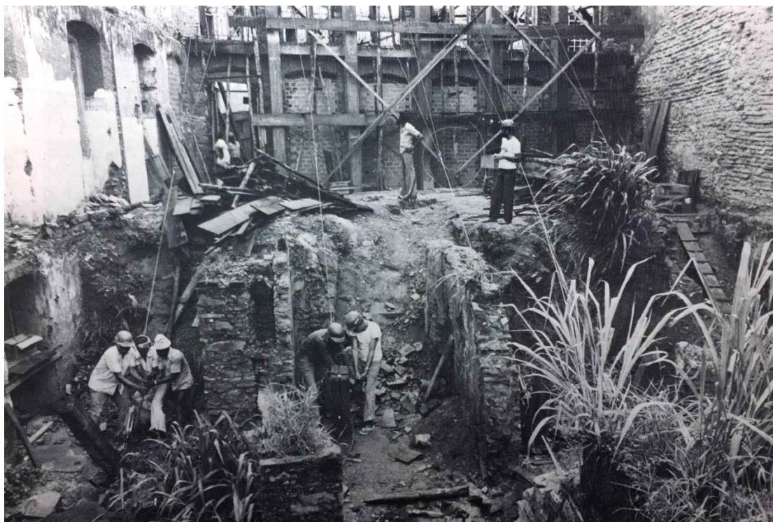
Figura 3 - Processo de restauração das fachadas dos imóveis nº 47, 49 e 51, vista interna. (BAHIA, 1978)
