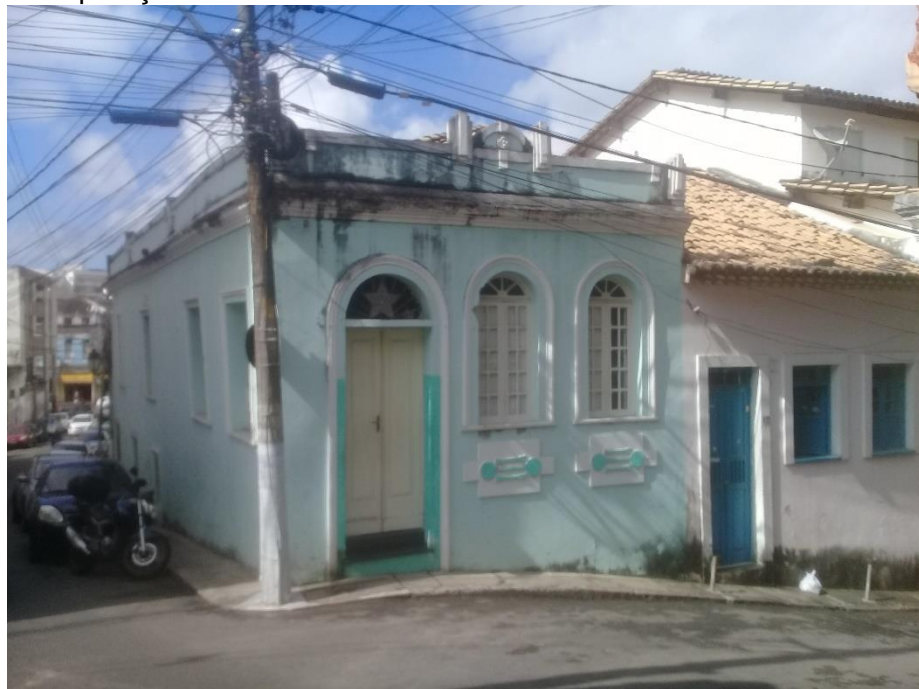
Figura 8. Imóvel nº 10 da Rua São Francisco depois da recuperação
