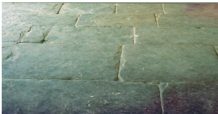
Figura 30 – Piso em ardósia da antiga casa da fazenda de Santo Inácio
