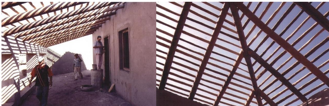
Figura 25 – Construção da casa paroquial de Santo Inácio – madeiramento em carnaúba
