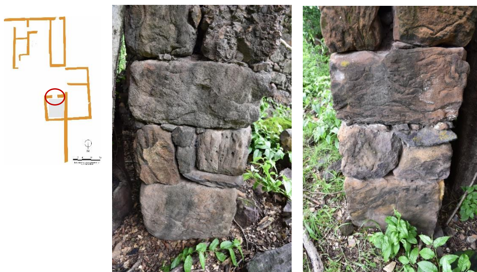
Figura 52 – Alvenaria em pedra aparelhada
