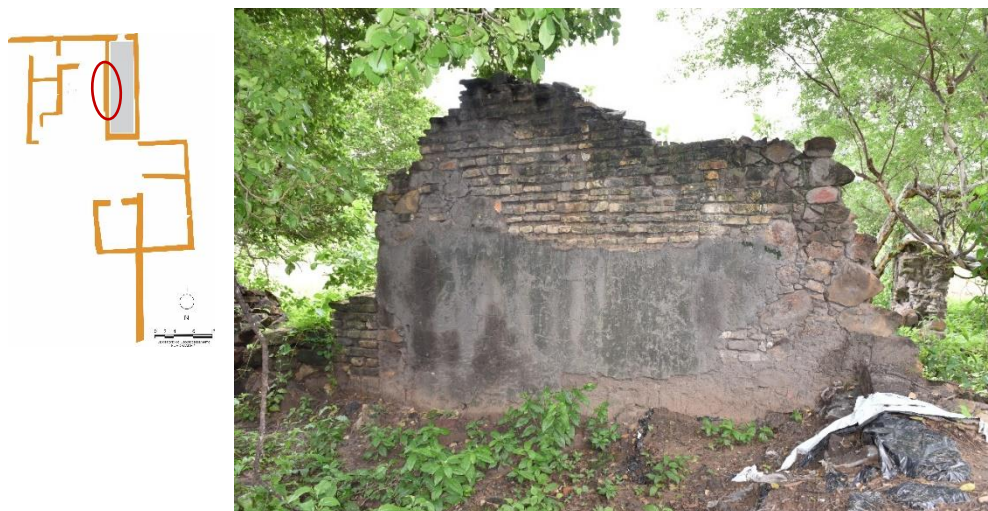
Figura 54 – Alvenaria mista em tijolo, pedra e cascalho
