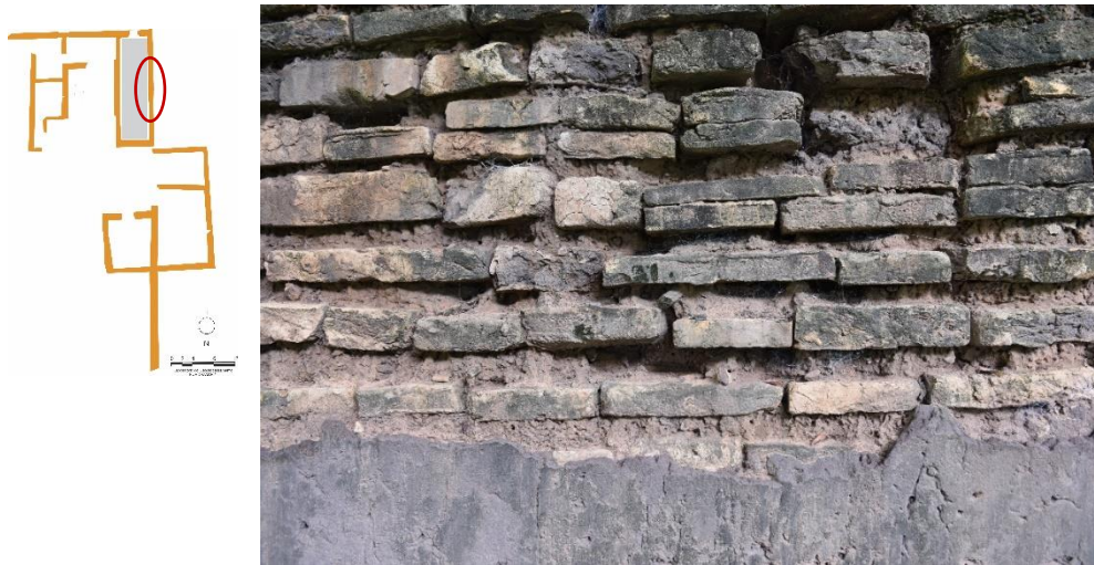
Figura 53 – Alvenaria em tijolos de tamanhos variados
