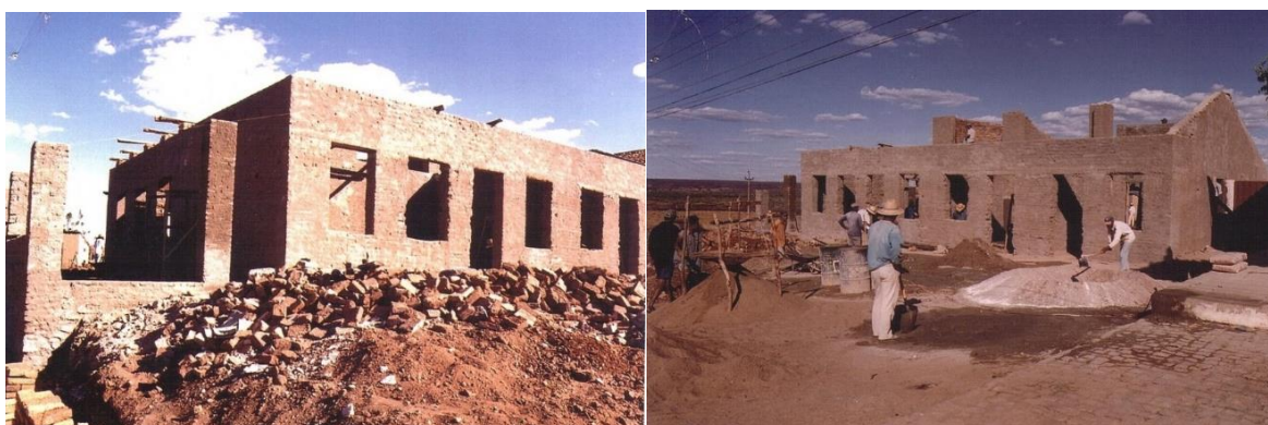
Figura 23 – Construção da casa paroquial da cidade de Santo Inácio – 1998
