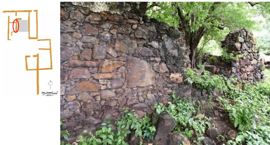
Figura 56 – Alvenaria em pedra e cascalho
