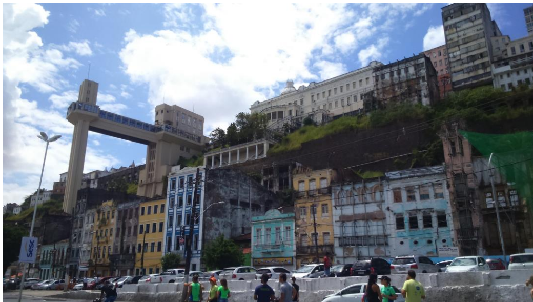
Figura 15: Vista do Bairro do Comércio
