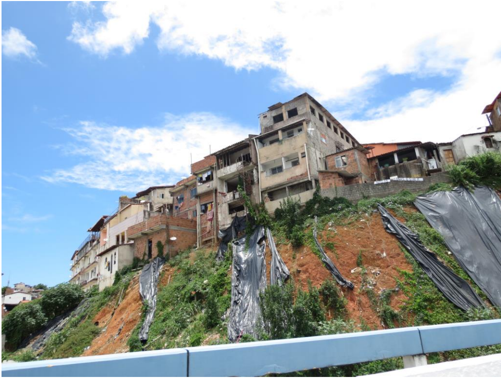
Figura 10: Vista do viaduto do Dique do Tororó sentido Avenida Vasco da Gama
